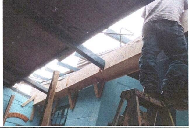
Foto 2: Mejoramiento de bajadas pluviales del establecimiento.
