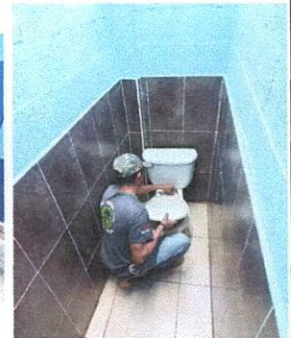
Foto 4: Mejoramiento de sanitarios del centro educativo.
